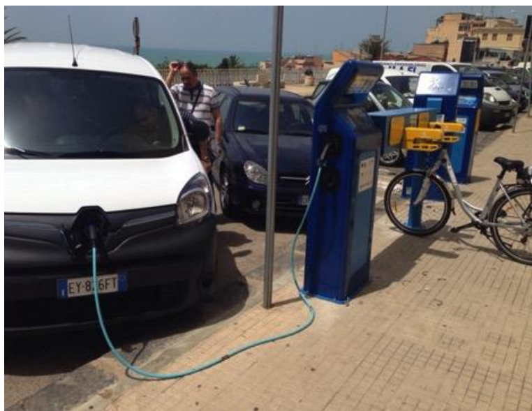
Figura 114 – Colonnine per la ricarica di mezzi elettrici
